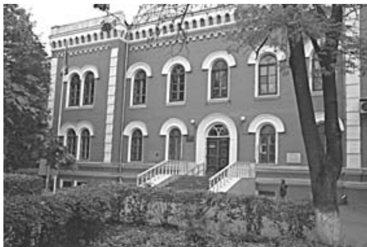
Главный корпус ВГТА
